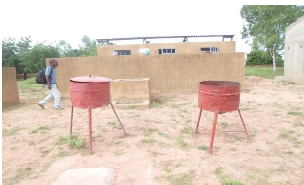
Image 3: Réservoir sans eau devant des latrines
