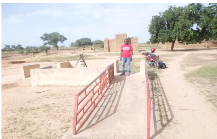
Image 5 : Clôture de PHM avec rampe d'accès pour handicapés
