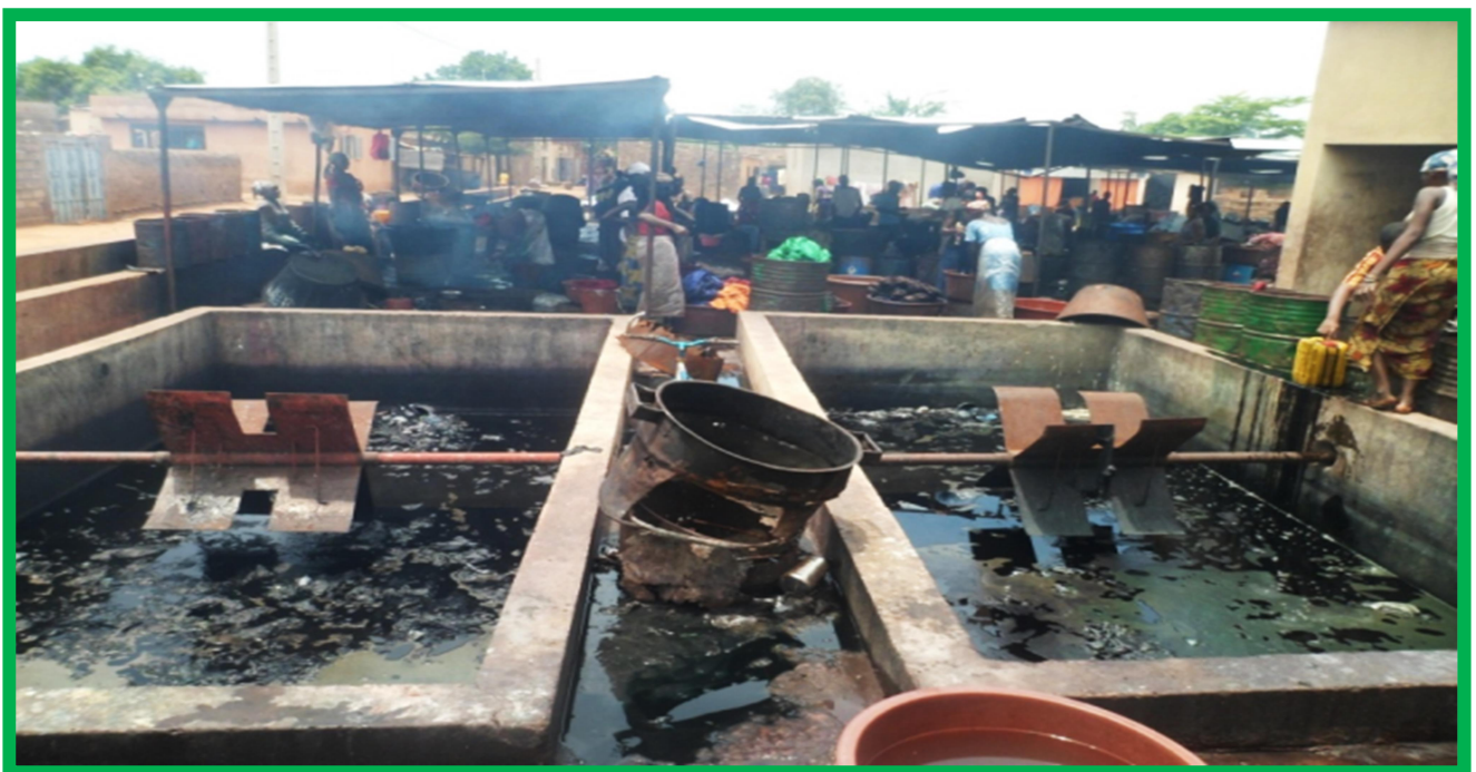
Figure 2 : Bassin de collecte du centre de teinturerie
